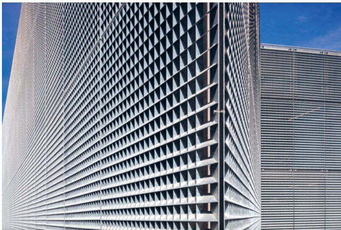
Der Querstab ist in einem Winkel von 45 Grad eingepresst und bildet so einen optimierten Kompromiss zwischen Luftdurchlass und Lichtschutz. La barre insérante est pressée à un angle de 45° pour fournir un compromis idéal entre protection contre la lumière et circulation de l'air.
